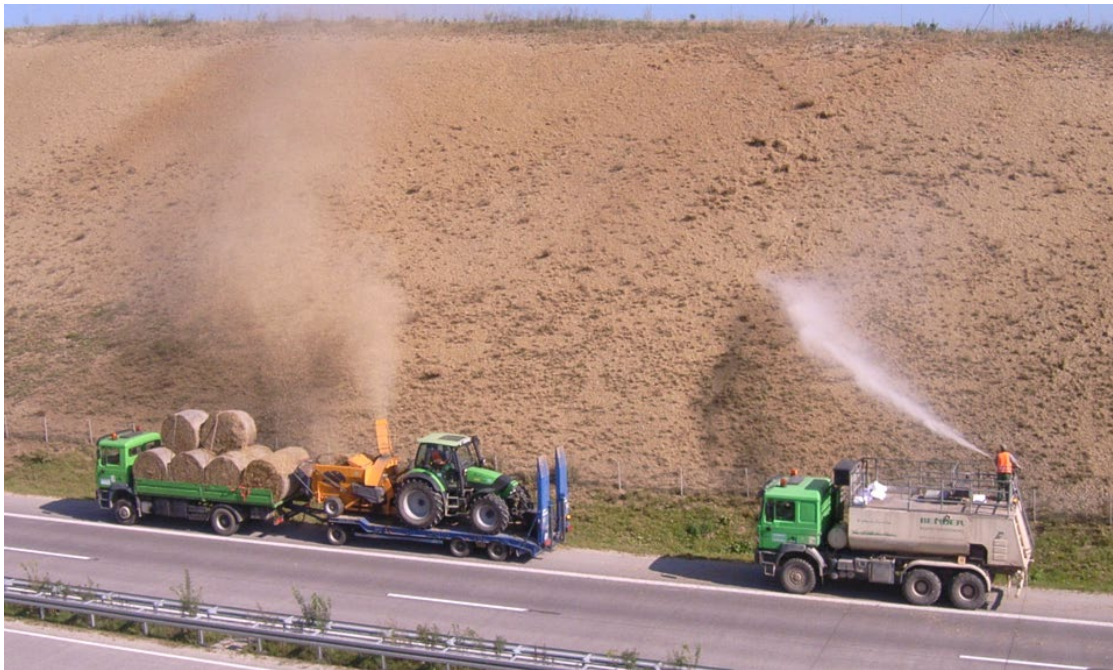
Abb. 1 Mähgut-Übertrag (Heumulchansaat) mittels Häcksler und Verkleben in zusätzlichem Arbeitsgang (Quelle: Fa. Bender)
