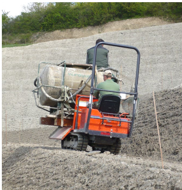
Abb. 2 Ausbringung von gehäckselttem Heumulch und den erforderlichen Zuschlagsstoffen mittels Nassansaat (Quelle: Fa. Bender)
